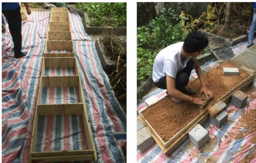
Hình 3. Chuẩn bị khuôn và lớp móng (ví dụ)
